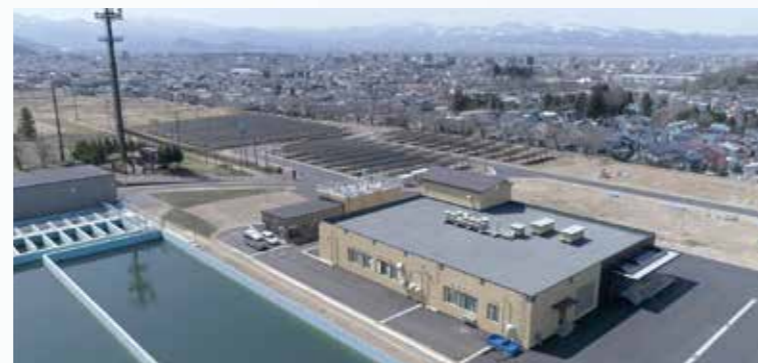
[写真1] 会津若松市の滝沢浄水場
